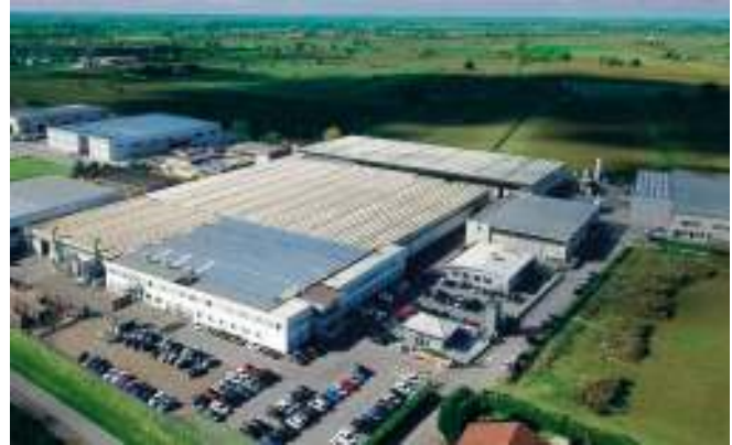
Рис. 1. Главный офис и фабрика Campitello.
